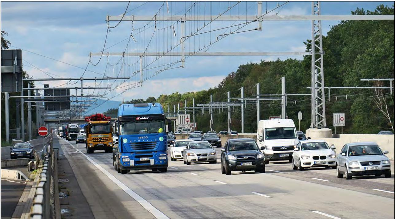
*Zwischen Frankfurt und Darmstadt wurden auf der A5 in beiden Richtungen erste Teststrecken von 5 km Länge eingerichtet, auf der LKW mit Stromabnehmern an die Oberleitung andocken und ihre Fahrakkus unterwegs aufladen können. Das Einrichten der Teststrecken kostete etwa 15 Mio. €. Bis Ende 2022 sollen hier Daten zu verkehrs- und energietechnischen, ökologischen und ökonomischen Fragen gesammelt werden, um die beste Variante für den künftigen Schwerlastverkehr auf der Straße zu erkunden.*
