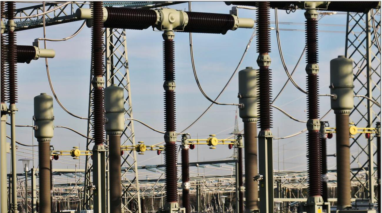
*In Umspann- und Lastverteilerwerken werden unterschiedliche Spannungsebenen so miteinander verschaltet, dass die angeschlossenen Verbraucherstationen mit der jeweils benötigten Energie versorgt werden. Neben Transformatoren und Schaltanlagen im Hochspannungsbereich werden auch viele Starkstromschalter und Starkstromisolatoren benötigt. Diese können auch Schutz- oder Isoliergase enthalten.*
