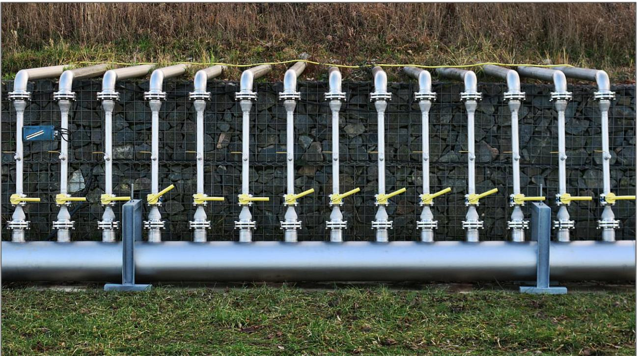
*Aus einem abgedeckten Deponiekörper treten Gasdrainageleitungen zutage, über die Deponiegas aufgefangen und in einer Sammelleitung zum Weiterbearbeiten transportiert wird. In Deponiegas sind bis zu 60 % Methan, enthalten. In Deutschland entstehen jährlich etwa 1,5 Mrd. Normkubikmeter an Methangas mit einem Energiegehalt von etwa 15.000 GWh aus Deponien.*
